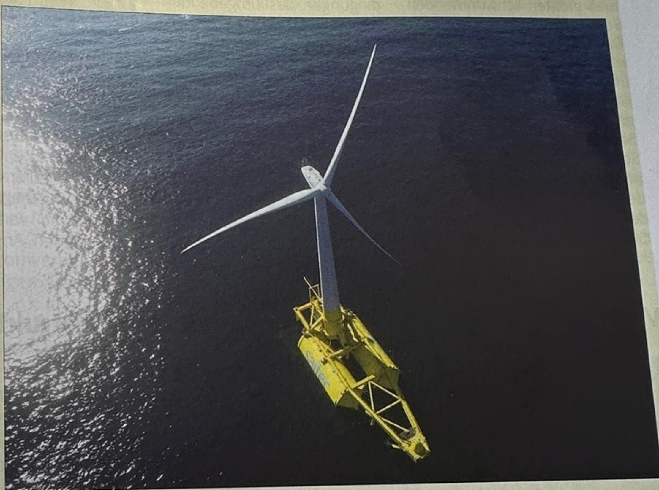
Die Plattform auf Betonbasis verfügt über nur einen Verankerungspunkt
