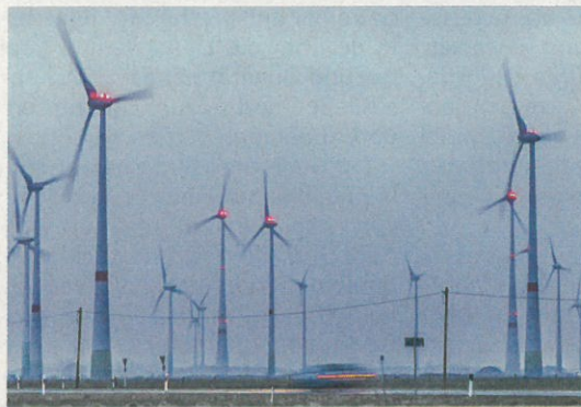
Nächtliches Dauerblinker von Windkraftanlagen soll der Vergangenheit angehören. Foto: imago
