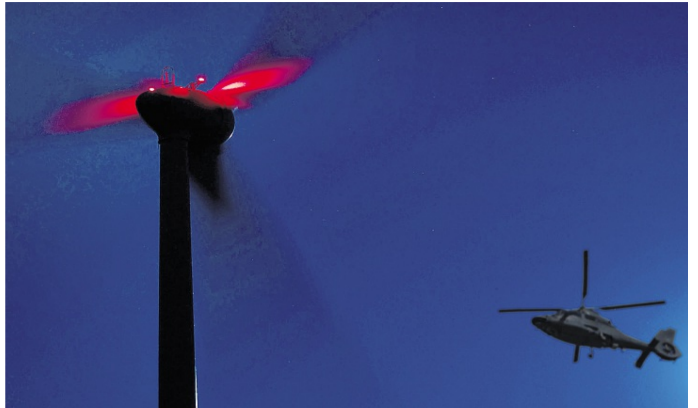
Windkraftanlagen sollen künftig nur bei Annäherung von Flugzeugen und Hubschraubern blinken.
