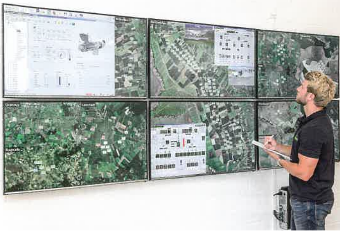
Die Monitore zeigen die Leistung jeder einzelnen Windenergieanlage von mehreren Windparks auf einen Blick an.
