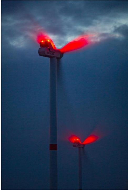
Bedarfsgerechte Hindernisbefeuerung bedeutet, dass die Befeuerung nur aktiviert wird, wenn sich ein Flugobjekt im Luftraum befindet.
